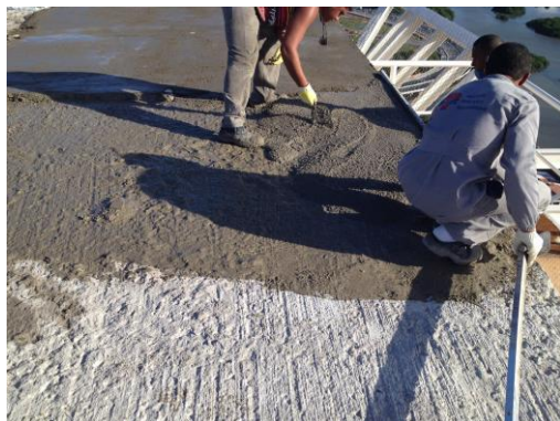
REGULARIZAÇÃO DO SUBSTRATO COM MICROCONCRETO
