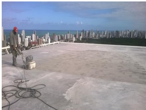
FRESAMENTO DO MICROCONCRETO PARA RECEBER O REVESTIMENTO ARGAMASSADO
