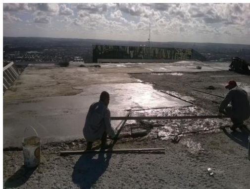
REGULARIZAÇÃO DO SUBSTRATO COM MICROCONCRETO
