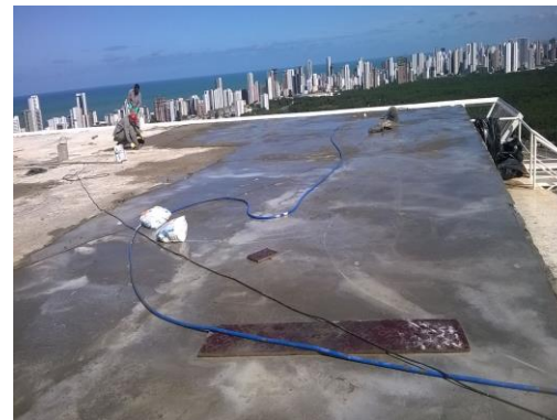
REGULARIZAÇÃO DO SUBSTRATO COM MICROCONCRETO
