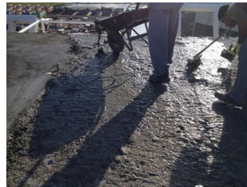
REGULARIZAÇÃO DO SUBSTRATO COM MICROCONCRETO
