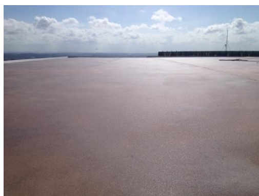
REVESTIMENTO ARGAMASSADO
