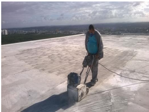
FRESAMENTO DO MICROCONCRETO PARA RECEBER O REVESTIMENTO ARGAMASSADO
