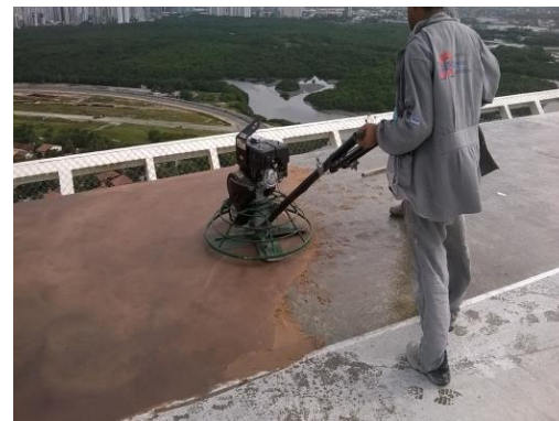
APLICAÇÃO DE PRIMER + REVESTIMENTO ARGAMASSADO
