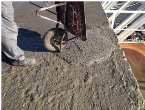
REGULARIZAÇÃO DO SUBSTRATO COM MICROCONCRETO
