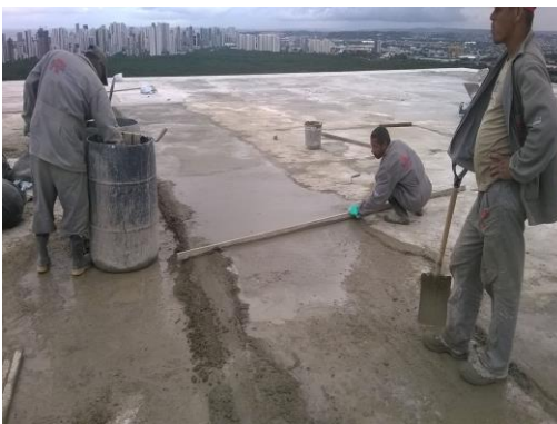
REGULARIZAÇÃO DO SUBSTRATO COM MICROCONCRETO
