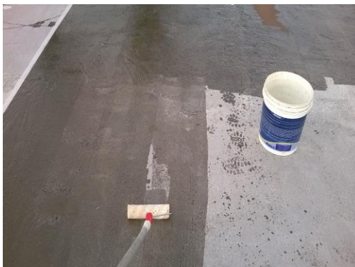
APLICAÇÃO DE PRIMER + REVESTIMENTO ARGAMASSADO
