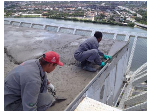
REGULARIZAÇÃO DO SUBSTRATO COM MICROCONCRETO
