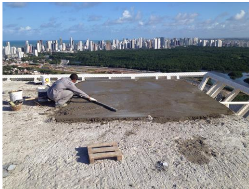
REGULARIZAÇÃO DO SUBSTRATO COM MICROCONCRETO
