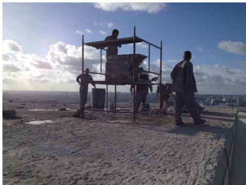
REGULARIZAÇÃO DO SUBSTRATO COM MICROCONCRETO
