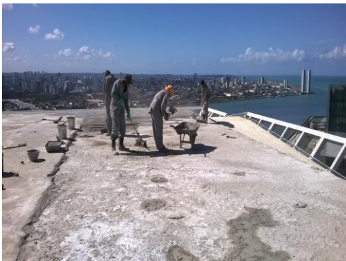
REGULARIZAÇÃO DO SUBSTRATO COM MICROCONCRETO
