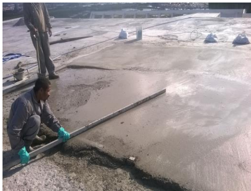
REGULARIZAÇÃO DO SUBSTRATO COM MICROCONCRETO
