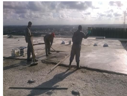
REGULARIZAÇÃO DO SUBSTRATO COM MICROCONCRETO
