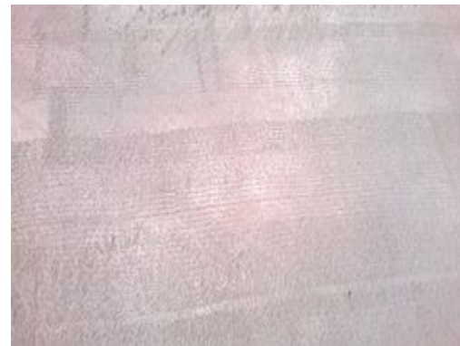
FRESAMENTO DO MICROCONCRETO PARA RECEBER O REVESTIMENTO ARGAMASSADO
