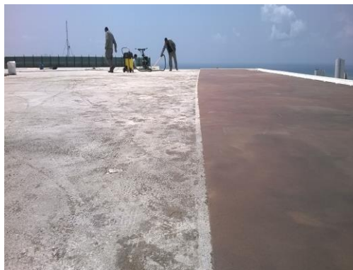
REVESTIMENTO ARGAMASSADO
