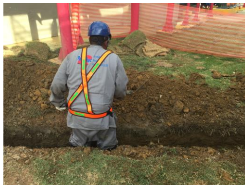
escavação para instalação de tubulação e caixa de drenagem e limpeza
