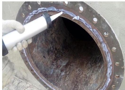
Execução de revestimento epóxi
