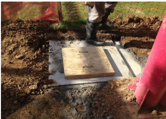
Instalação de caixa de passagem e recomposição da grama
