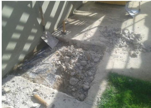
execução de caixa de passagem
