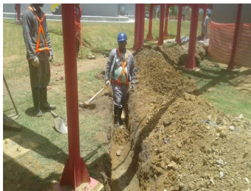
escavação para instalação de tubulação e caixa de drenagem e limpeza
