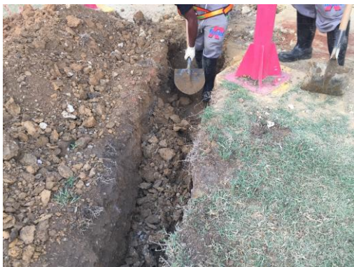
escavação para instalação de tubulação e caixa de drenagem e limpeza
