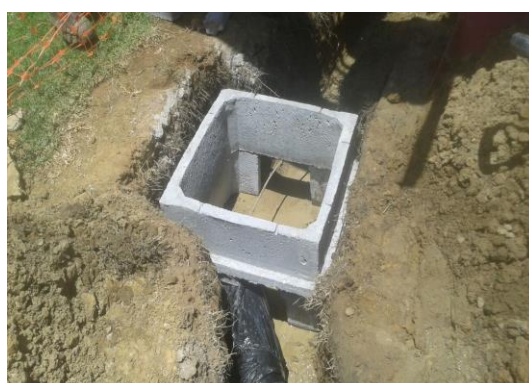
Instalação de caixa de passagem
