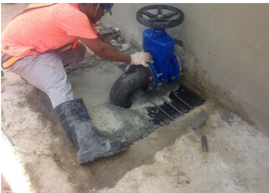
recuperação das canaletas e instalação das cantoneiras
