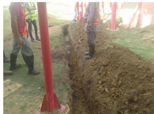
escavação para instalação de tubulação e caixa de drenagem e limpeza
