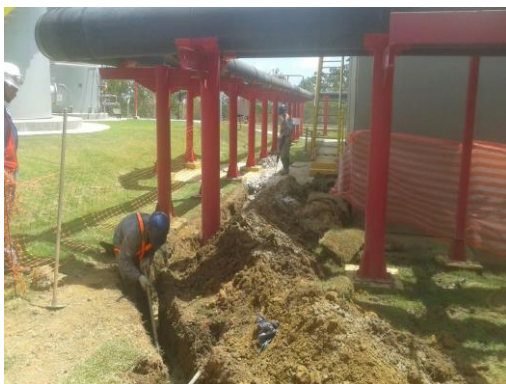
escavação para instalação de tubulação e caixa de drenagem e limpeza
