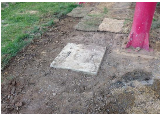
Instalação de caixa de passagem e recomposição da grama
