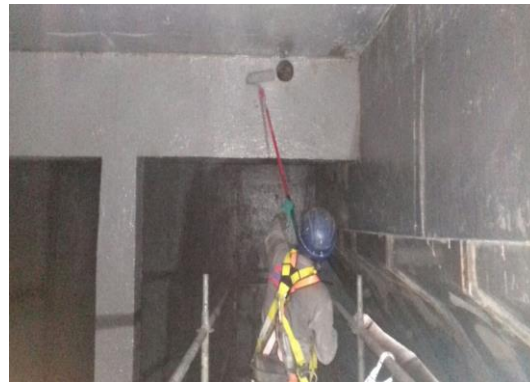
Execução de revestimento base epóxi
