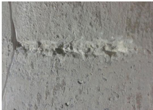
Recuperação localizada de fissuras
