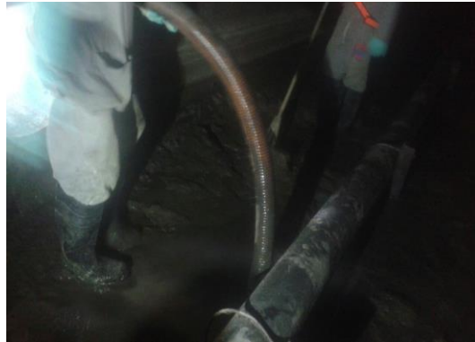
drenagem e limpeza interna do tanque
