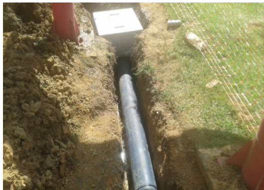
Instalação de caixa de passagem
