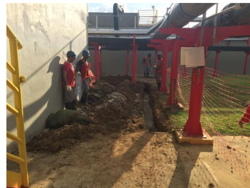
escavação para instalação de tubulação e caixa de drenagem e limpeza
