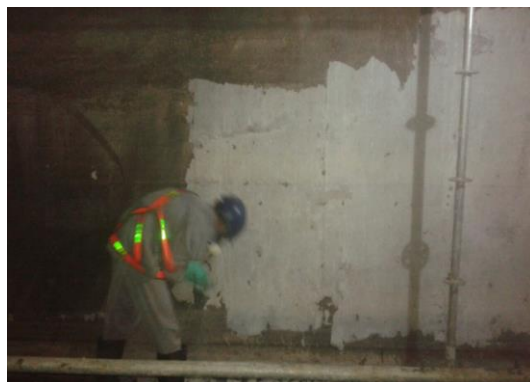
Preparação do substrato - lixamento
