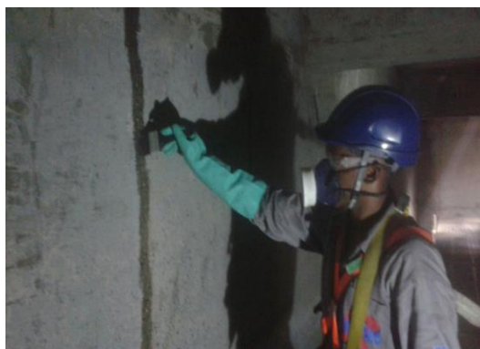
Recuperação localizada de fissuras
