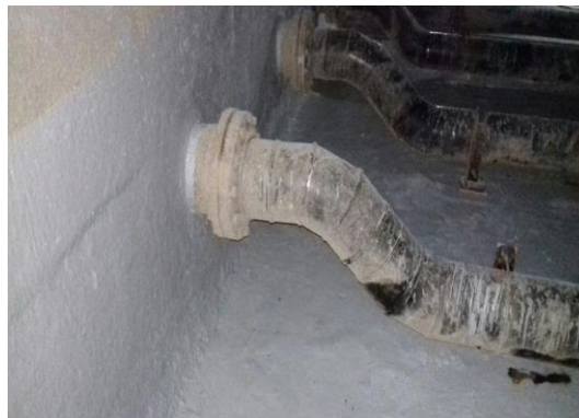
Execução de revestimento epóxi
