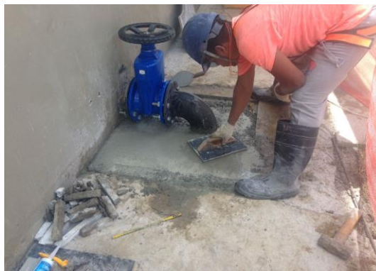
recuperação das canaletas e instalação das cantoneiras
