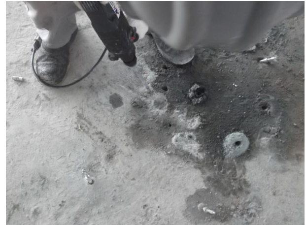
FURAÇÃO - INSTALAÇÃO DOS BICOS DE PERFURAÇÃO
