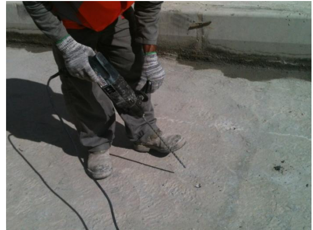
FURAÇÃO - INSTALAÇÃO DOS BICOS DE PERFURAÇÃO
