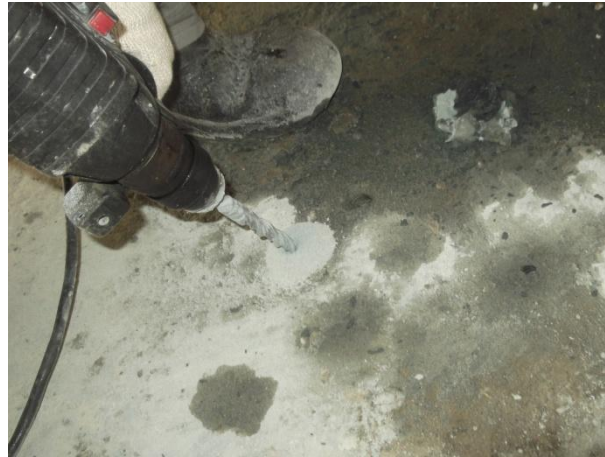
FURAÇÃO - INSTALAÇÃO DOS BICOS DE PERFURAÇÃO
