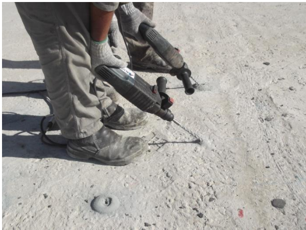
FURAÇÃO - INSTALAÇÃO DOS BICOS DE PERFURAÇÃO
