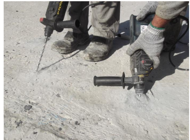
FURAÇÃO - INSTALAÇÃO DOS BICOS DE PERFURAÇÃO
