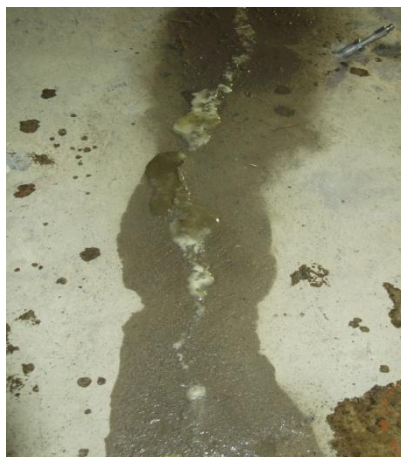
APLICAÇÃO DE ESPUMA DE PU 2033
