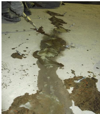
APLICAÇÃO DE GEL DE PU – MC-DUR 2300 NV
