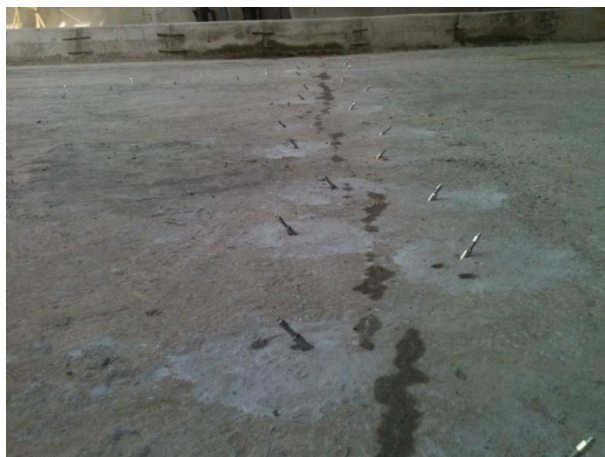
BICOS DE PERFURAÇÃO INSTALADOS
