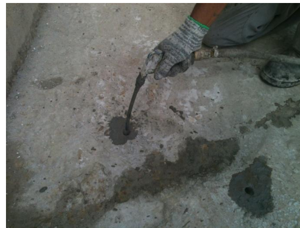
LIMPEZA - INSTALAÇÃO DOS BICOS DE PERFURAÇÃO
