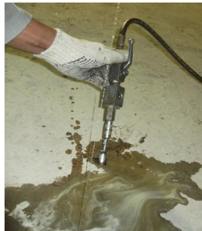
APLICAÇÃO DE GEL DE PU – MC-DUR 2300 NV
