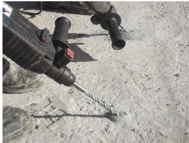
FURAÇÃO - INSTALAÇÃO DOS BICOS DE PERFURAÇÃO
