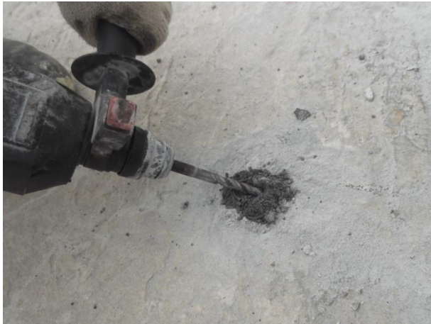
FURAÇÃO - INSTALAÇÃO DOS BICOS DE PERFURAÇÃO
