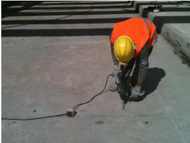
FURAÇÃO - INSTALAÇÃO DOS BICOS DE PERFURAÇÃO
