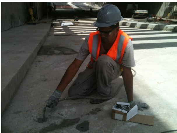
LIMPEZA - INSTALAÇÃO DOS BICOS DE PERFURAÇÃO
