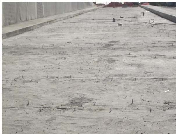
BICOS DE PERFURAÇÃO INSTALADOS
