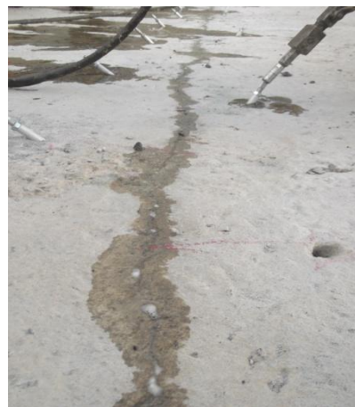
APLICAÇÃO DE ESPUMA DE PU 2033
