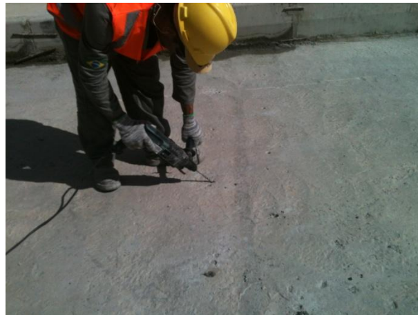
FURAÇÃO - INSTALAÇÃO DOS BICOS DE PERFURAÇÃO
