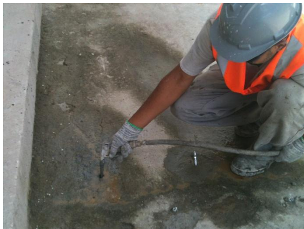
LIMPEZA - INSTALAÇÃO DOS BICOS DE PERFURAÇÃO
