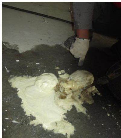
APLICAÇÃO DE ESPUMA DE PU – MC-DUR 2033
