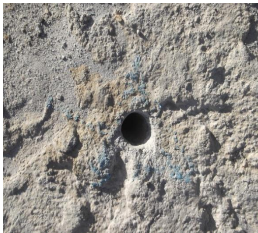
FUROS – INSTALAÇÃO DOS BICOS DE PERFURAÇÃO
