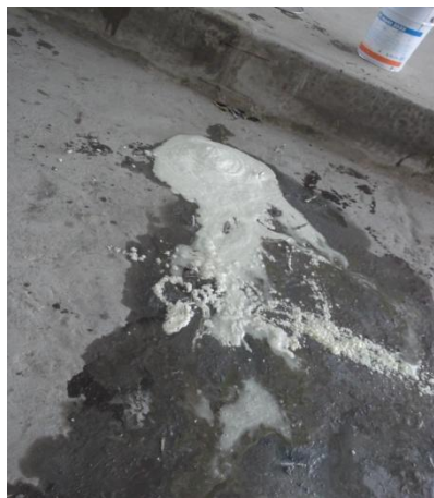
APLICAÇÃO DE ESPUMA DE PU – MC-DUR 2033
