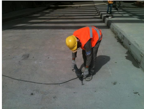
FURAÇÃO - INSTALAÇÃO DOS BICOS DE PERFURAÇÃO
