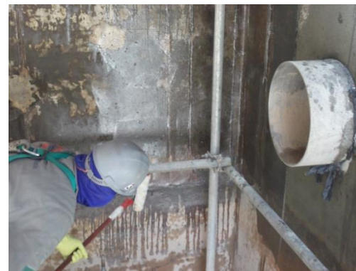
PREPARAÇÃO DO SUBSTARTO (APLICAÇÃO DE PRIMER)
