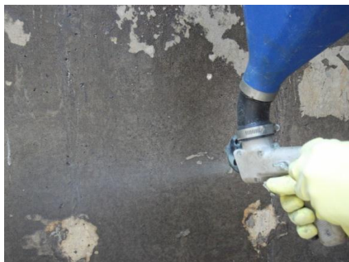
PREPARAÇÃO DO SUBSTARTO (ESTUCAMENTO COM AREIA WR)
