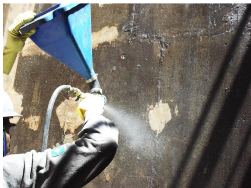
PREPARAÇÃO DO SUBSTARTO (ESTUCAMENTO COM AREIA WR)
