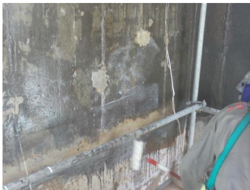
PREPARAÇÃO DO SUBSTARTO (APLICAÇÃO DE PRIMER)
