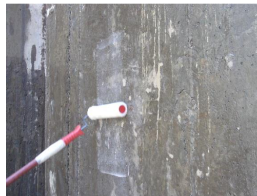
PREPARAÇÃO DO SUBSTARTO (APLICAÇÃO DE PRIMER)
