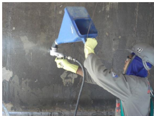
PREPARAÇÃO DO SUBSTARTO (ESTUCAMENTO COM AREIA WR)
