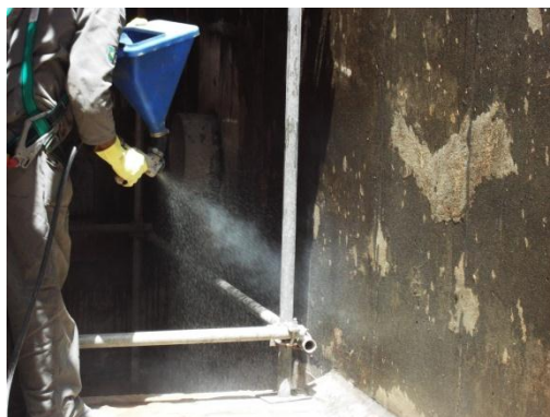
PREPARAÇÃO DO SUBSTARTO (ESTUCAMENTO COM AREIA WR)
