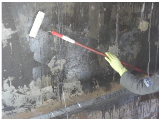
PREPARAÇÃO DO SUBSTARTO (APLICAÇÃO DE PRIMER)
