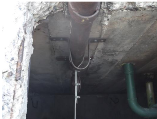
INSTALAÇÃO DE EQUIPAMENTOS (GHUINCHO E MÃO FRANCESA)
