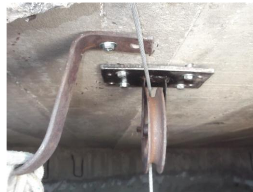
INSTALAÇÃO DE EQUIPAMENTOS (GHUINCHO E MÃO FRANCESA)
