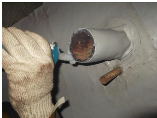
INSTALAÇÃO DE MANTA DE PVC (DETALHES DOS DUTOS)
