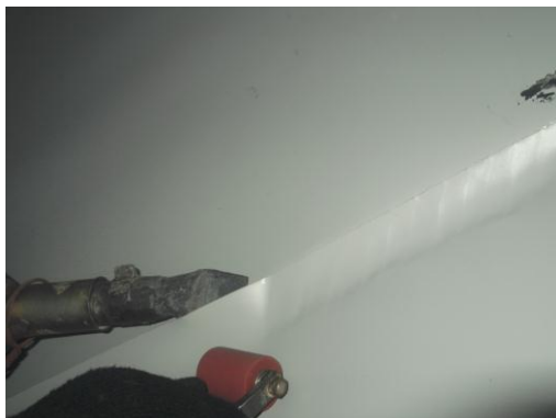
INSTALAÇÃO DE MANTA DE PVC
