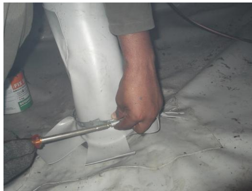
INSTALAÇÃO DE MANTA DE PVC (DETALHES DOS DUTOS)
