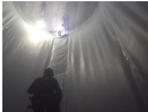
INSTALAÇÃO DE MANTA DE PVC
