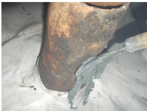
INSTALAÇÃO DE MANTA DE PVC (DETALHES DOS DUTOS)
