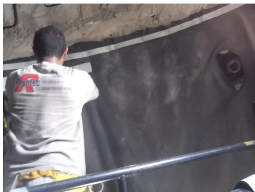
INSTALAÇÃO DE CAMADA SEPARADORA (BIDIM) E PERFIS COLAMINADOS
