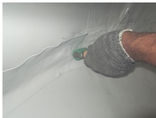
INSTALAÇÃO DE MANTA DE PVC
