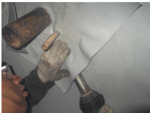
INSTALAÇÃO DE MANTA DE PVC (DETALHES DOS DUTOS)
