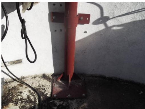
INSTALAÇÃO DE EQUIPAMENTOS (GHUINCHO E MÃO FRANCESA)
