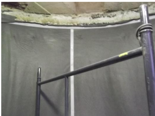
INSTALAÇÃO DE CAMADA SEPARADORA (BIDIM) E PERFIS COLAMINADOS
