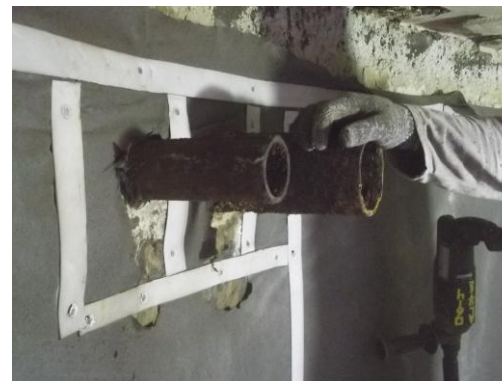
INSTALAÇÃO DE CAMADA SEPARADORA (BIDIM) E PERFIS COLAMINADOS
