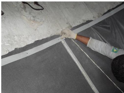
INSTALAÇÃO DE CAMADA SEPARADORA (BIDIM) E PERFIS COLAMINADOS
