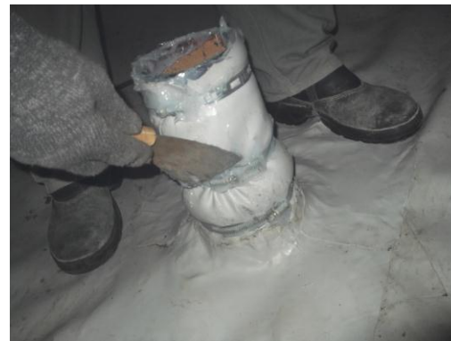
INSTALAÇÃO DE MANTA DE PVC (DETALHES DOS DUTOS)
