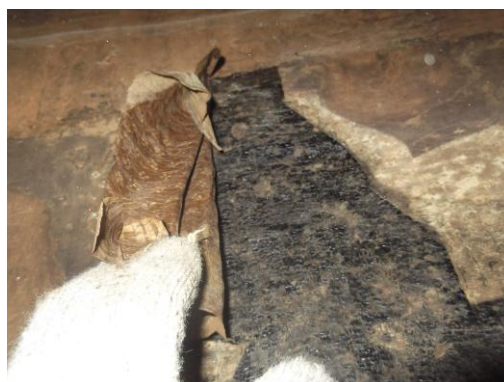
INSPEÇÃO INTERNA DA MANTA ASFALTICA
