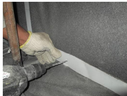
INSTALAÇÃO DE CAMADA SEPARADORA (BIDIM) E PERFIS COLAMINADOS
