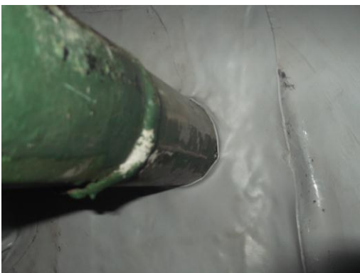
INSTALAÇÃO DE MANTA DE PVC (DETALHES DOS DUTOS)
